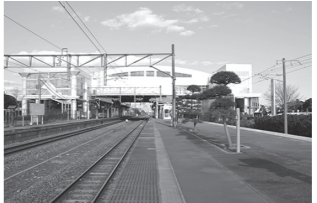
●2面3線のホームで橋上に駅舎がある。
