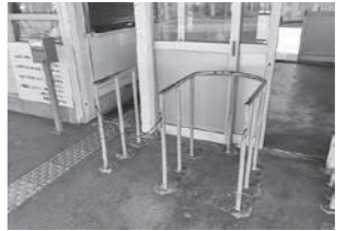
●鉄製の改札ラッチ。かつてはここで駅員が切符に切り込みを入れていた。
