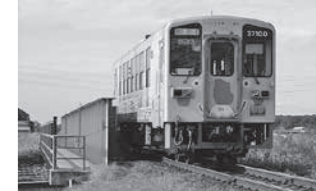
●駅のすぐ西側にある中丸川橋梁
