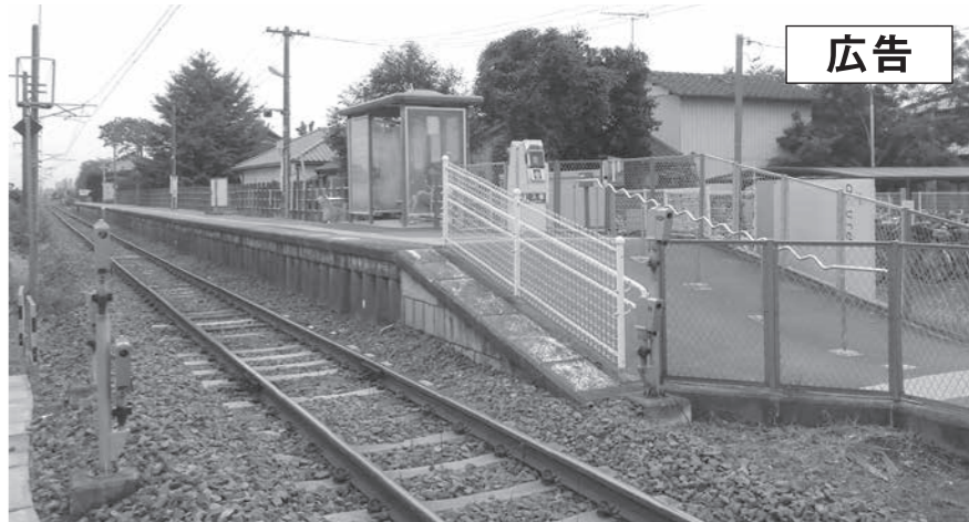
●単式ホーム1面1線の地上駅。駅舎はなく、ホームに待合室があり、駅入口には改札機と乗車証明書発行機が設置されている。 ●平成21年に改良された待合室。 ●ホームに停車するE501系。
