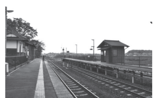
●相対式2面2線のホーム間は構内踏切で連絡している。
