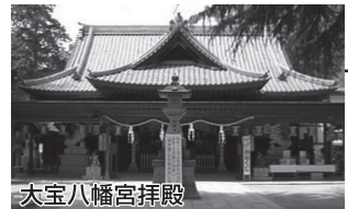
大宝八幡宮拝殿 ●御祈禱をはじめ祭事を執り行う御殿、奉獻者には勝海舟の名もある。
